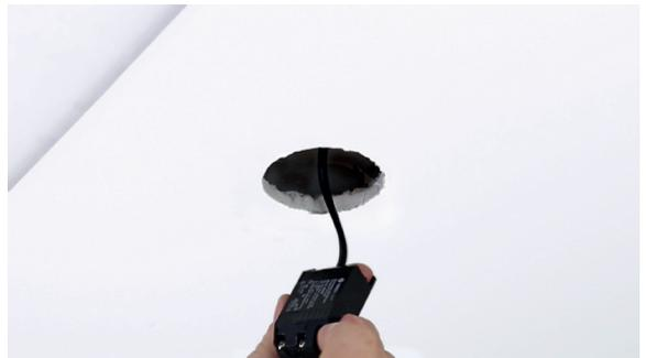
**3 - Kompaktes Netzgerät wird in den Hohlraum eingeschoben**
