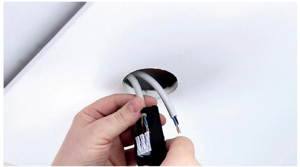
**1 - Schnelle Verkabelung / Durchgangsverdrahtung an der Quick-Anschlussbox durch schraublose Steckklemmen, auch für 3x 1,5 mm<sup>2</sup> NYM, Installationskabel inkl. Zugentlastung**
