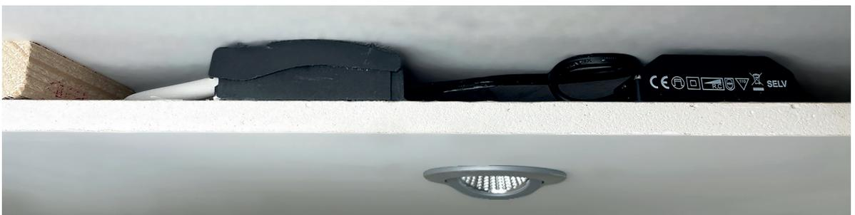
**6 - Das Ergebnis: eine kompakte Installation mit einem schwenkbaren Spot, einem dimmbaren Netzgerät sowie der Möglichkeit zur Durchgangsverdrahtung mittels Quick-Anschlussbox bei nur 25 mm Platzbedarf im Deckenhohlraum. Es wird kein zusätzliches Installationsmaterial benötigt – ideal im Sanierungsbereich.**
