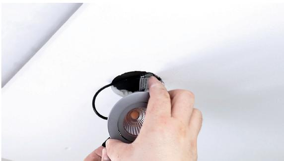
**4 - Einsetzen des Spots in den Deckenausschnitt**
